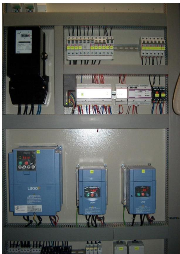
Slika 3: Elektroomara s krmiljem CyBro in frekvenčnimi pretvorniki Hitachi
